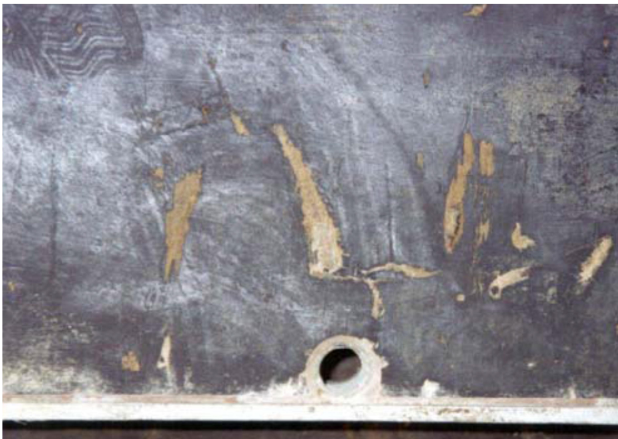
Afbeelding 2: niet toelaatbare beschadiging van de bekistinghuid (diepte groter dan 1 mm door dekfineer gedrukt)
