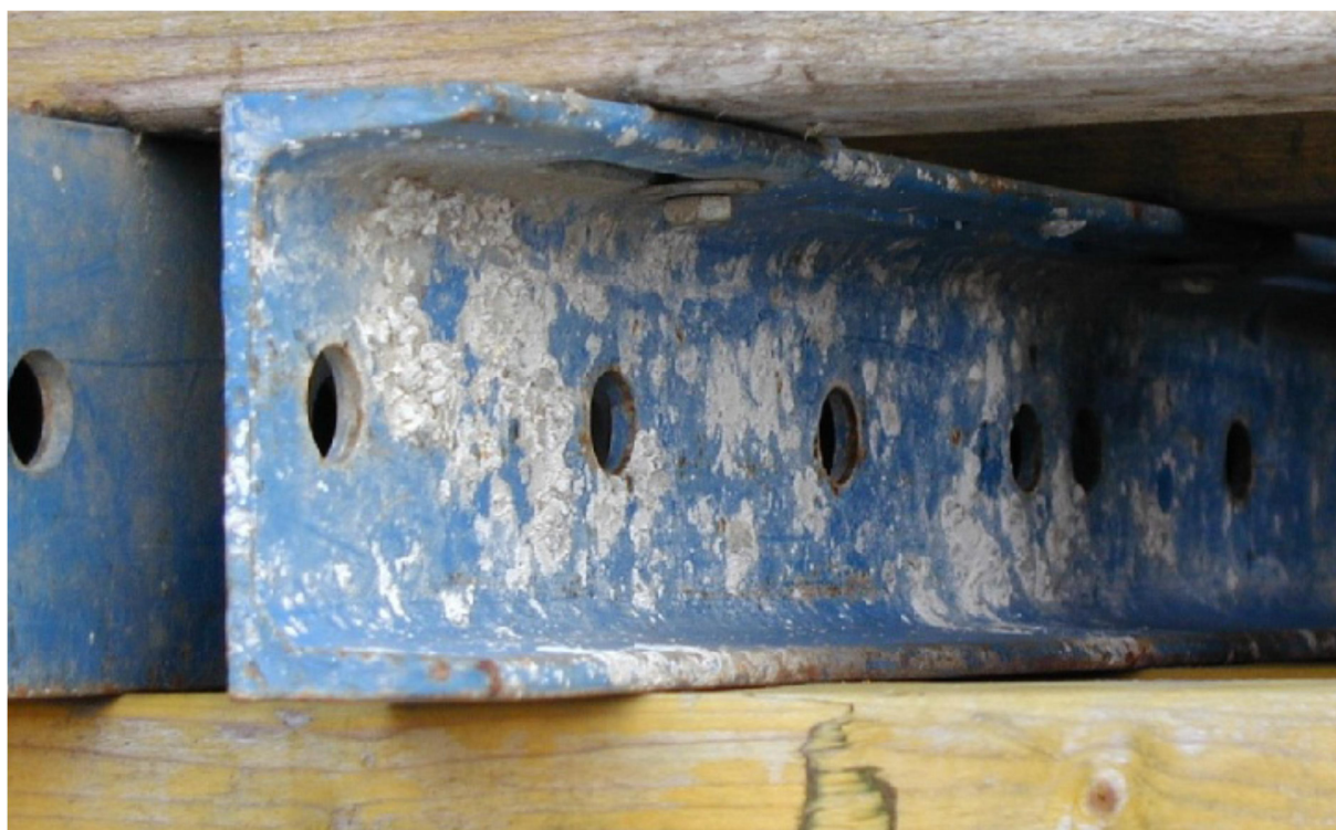
Afbeelding 7: toelaatbare betonresten op stalen gordingen
