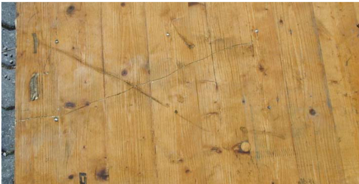
Afbeelding 4: toelaatbare beschadiging van oppervlak
