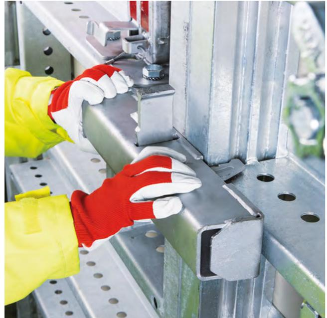
► Einfache und schnelle Tafelverbindung durch das Keilrichtschloss
