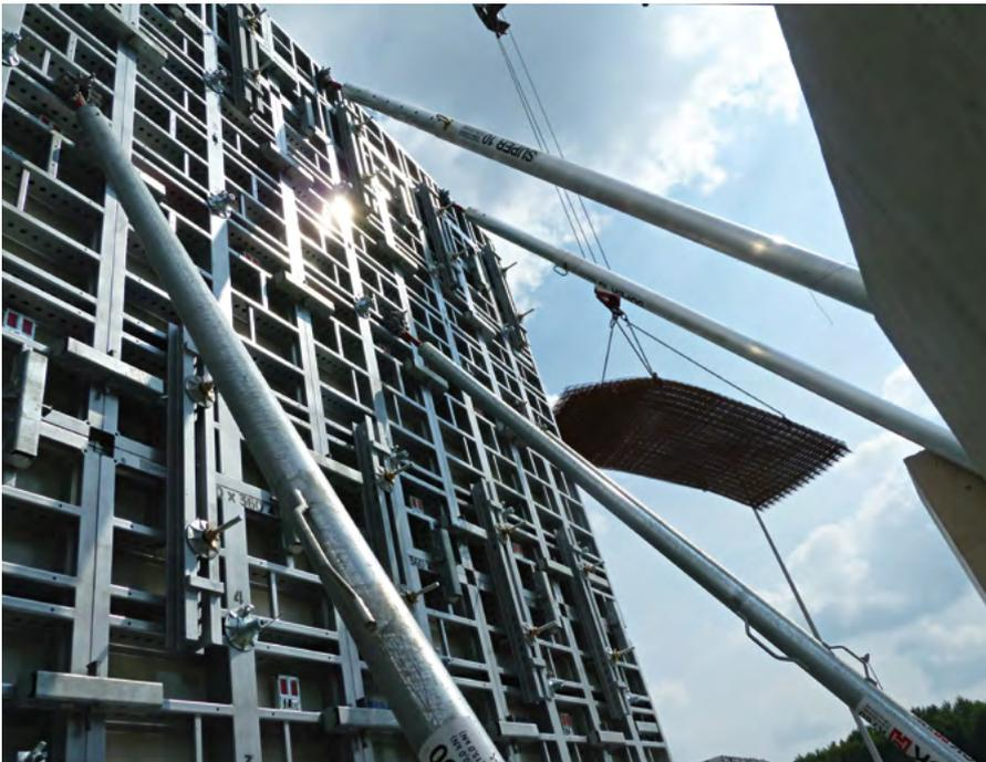
▶ 100 kN/m<sup>2</sup> Betondruck im gesamten System bei neuen SCC- und Flüssigbetontypen
