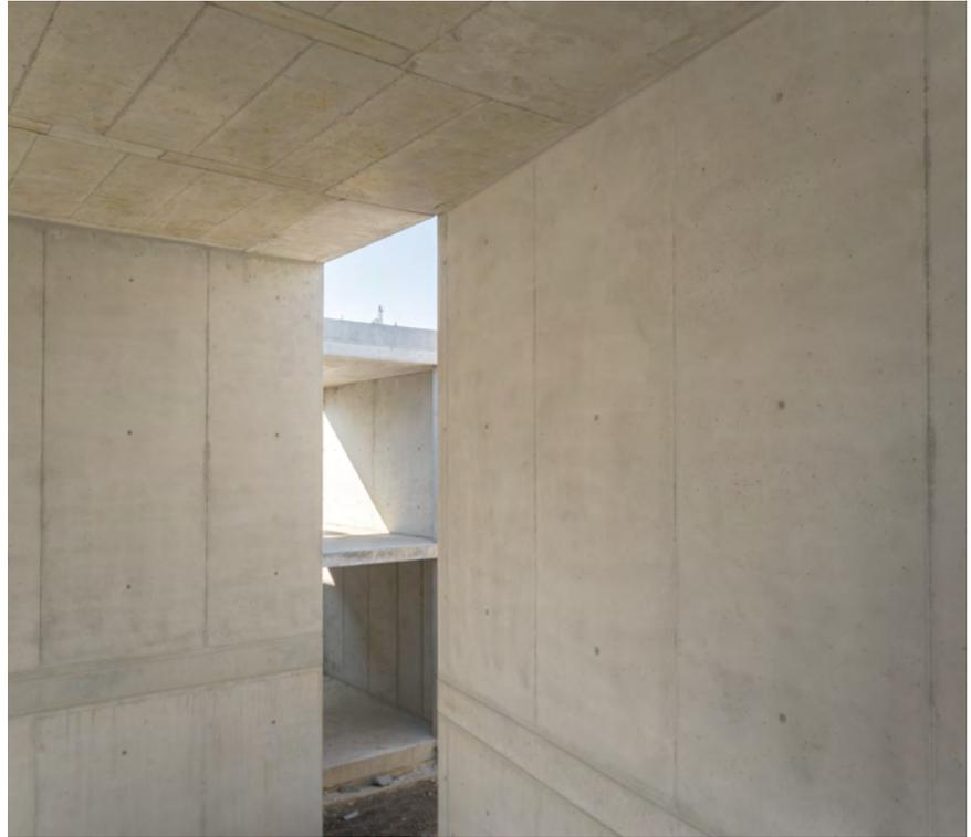
▶ Versatzfrei fluchtendes Verbinden und Fugenraster möglich, unabhängig davon, ob die Tafeln in vertikaler oder horizontaler Lage eingesetzt werden
