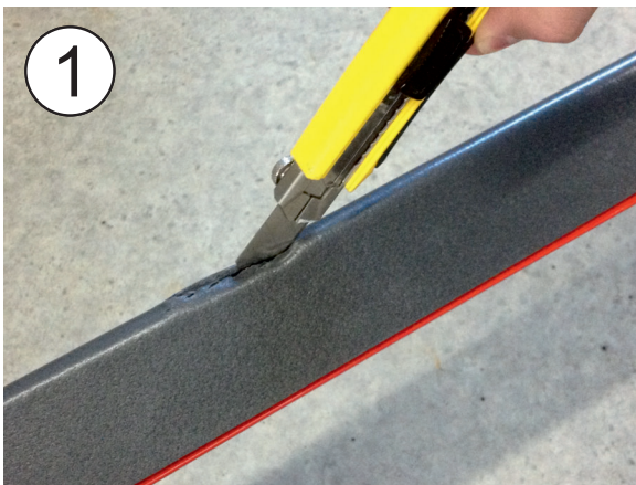
▲ FLUXX F6 Folie an den Aussparungen einschneiden
