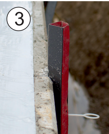
◀ FLUXX Abschalschiene in der Fuge arretieren
