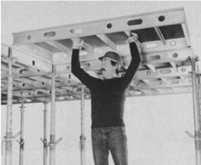
**1** Insérer les panneaux dans leurs supports en se positionnant dessous.
